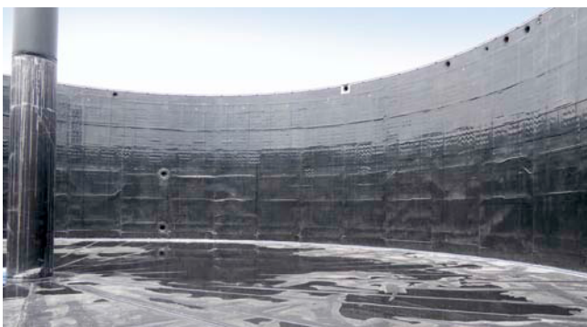
Fertig ausgekleideter Behälter mit Stütze und Leckageschutz. Die Behälterauskleidung nach System Dr. Kerner ermöglicht eine zügige und sichere Montage vor Ort.
